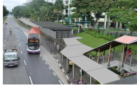
รูปที่ 12 ทางเชื่อมต่อรถเมล์ที่มีหลังคา
